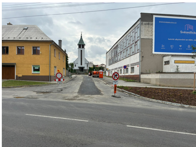
Oprava kanalizace na Svěsedlické ulici
