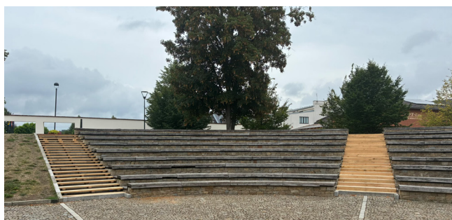
Oprava schodů v amfiteátru
