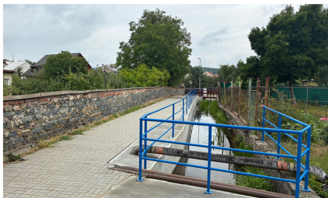
Oprava mostku a chodníku u bývalé pekárny
