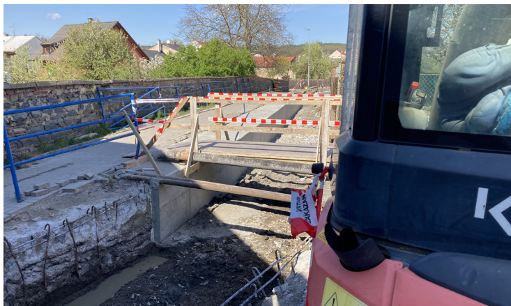
Rekonstrukce opěrné zdi u pekárny
