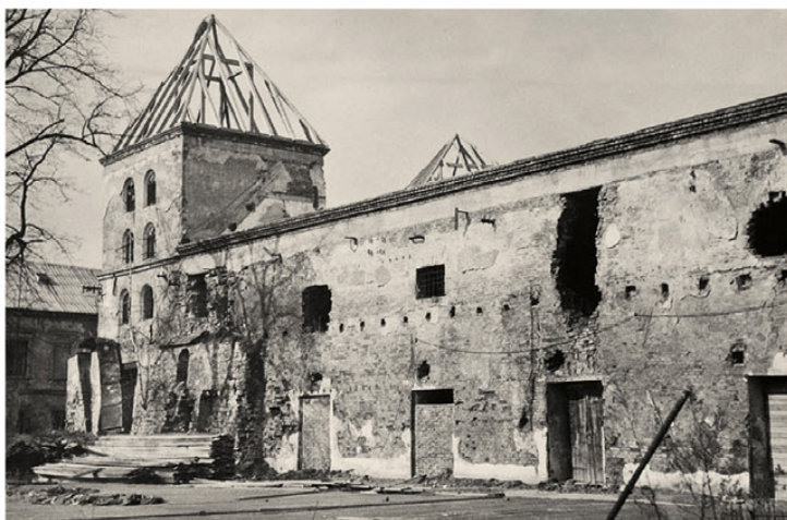
Zámek před rekonstrukcí
